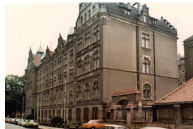
KD Bautzen Mättigstr. 37 BStU, MfS, BV Dresden, KD Bautzen, Nr. 9542, Bild 1
