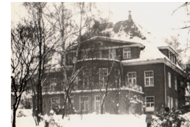
KD Pirna Postweg BStU, MfS, BV Dresden, KD Pirna, Nr. 70261, Bl. 6, Bild 1
